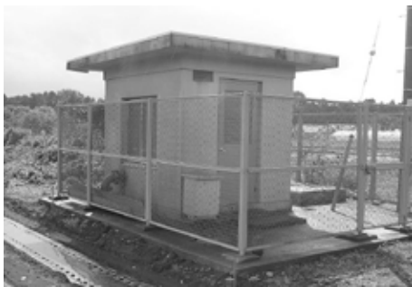
取水井戸からポンプで汲み上げられた地下水は、浄水場でろ過・滅菌された後に配・給水管で各家庭に水道水として供給される (5号井戸・山野地内)
