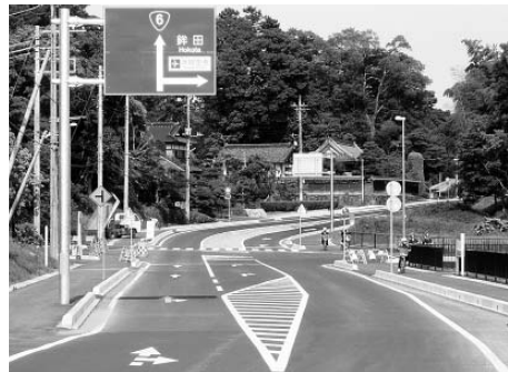
乗越(のっこし)橋までの2.6km区間を整備予定(羽鳥宿張星線東ルート・張星地内)
