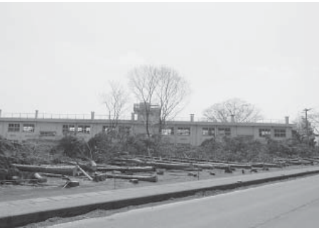
22年度当初予算に小中学校建設費6億7,000万円を計上。国施策の後押しを受け学校耐震化を推進する(H22-23継続事業として校舎改築を行う堅倉小学校)
