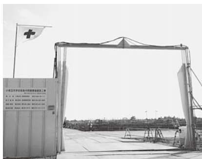
市のほぼ中央部、広域農道メロンロードの交差点からも至近の場所に位置する給食センター建設予定地 (1月4日時点・野田地内)
