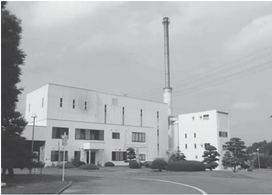
老朽化が目立つ茨城美野里環境組合(美野里地区と茨城町のごみ処理施設)
