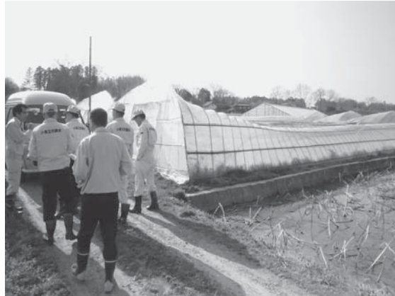
市内の被害状況調査（玉里地内）
