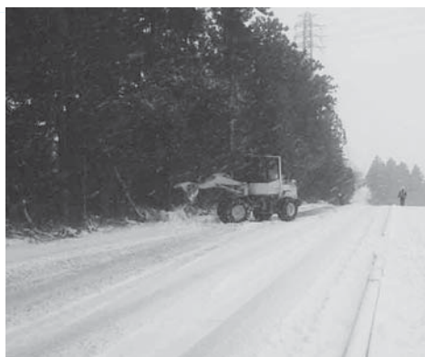
建設業協会による除雪作業 (メロンロード)
