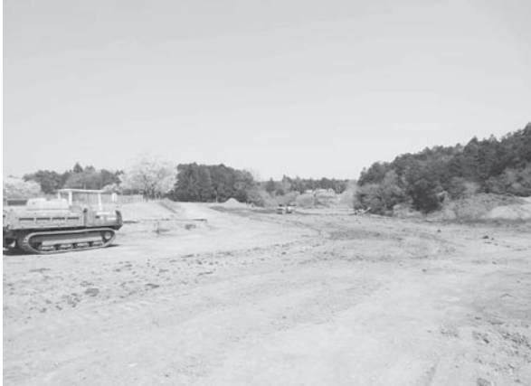
現在改修工事中の玉里運動公園
