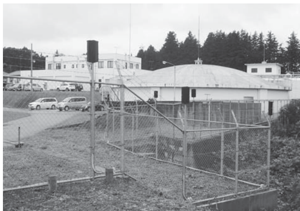
災害時の停電対策もとられている市内浄水場 (美野里浄水場)
