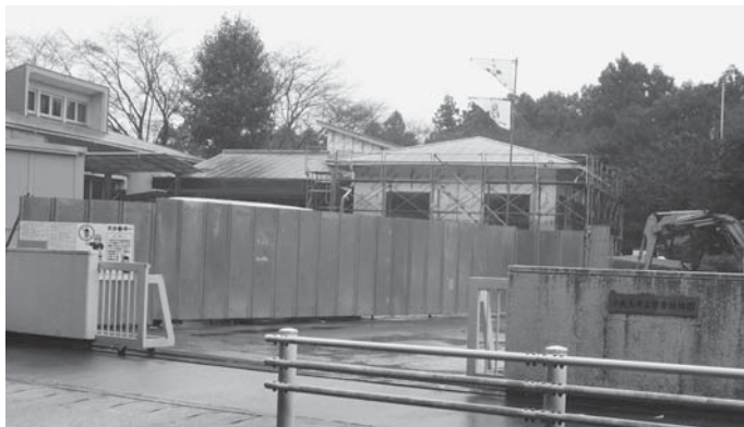
耐震化工事が進む堅倉幼稚園
