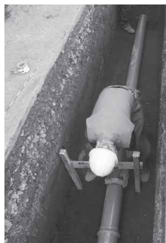
下水道管布設状況
