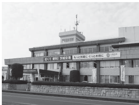
耐震工事が行われる小川総合支所
