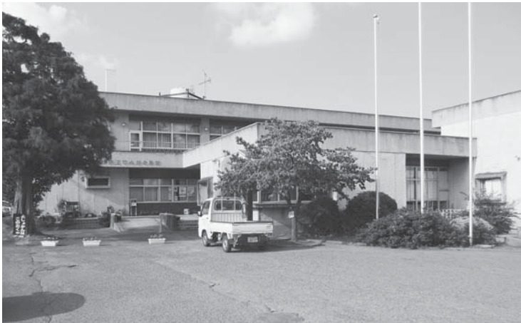
老朽化が進む公共施設
