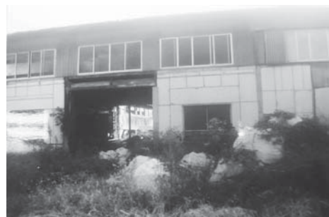
放置されている空き家
