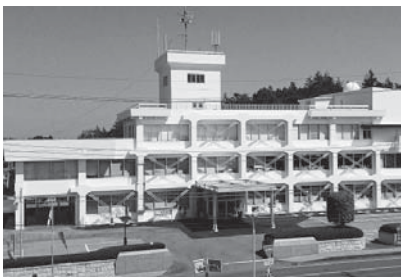
小川総合支所耐震補強工事した。例債等、他の有利な財源を活用した。
