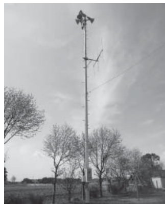
更新工事が完了した防災行政無線屋外子局（伏沼）
