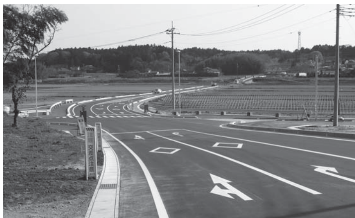
整備が進められている（仮称）栗又四ヶ線（上馬場地内のようす）
