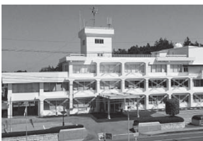
小川総合支所耐震補強工事した。例債等、他の有利な財源を活用した。
