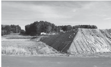
栗又四ヶ線工事の現場
