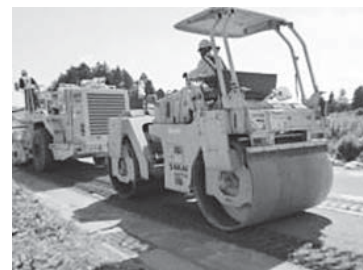
道路維持補修の様子
