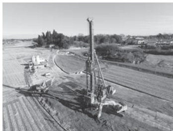
工事の進む茨城空港アクセス道路（竹原地内）
