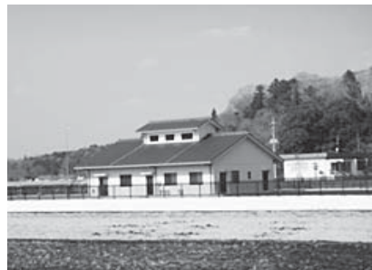
農業集落排水施設
