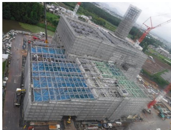
(工事状況 6/30時点 進捗率75.2%)
