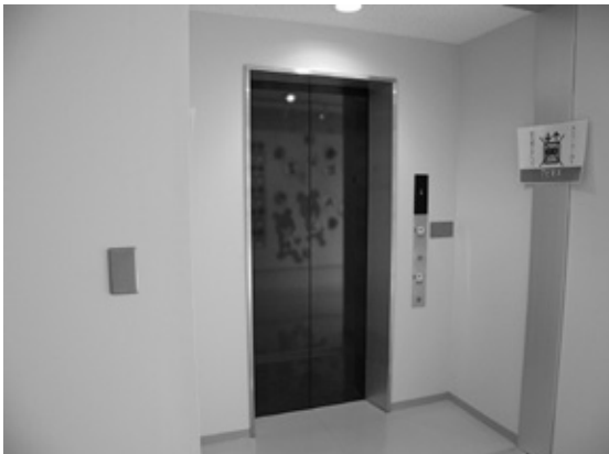
エレベーター
