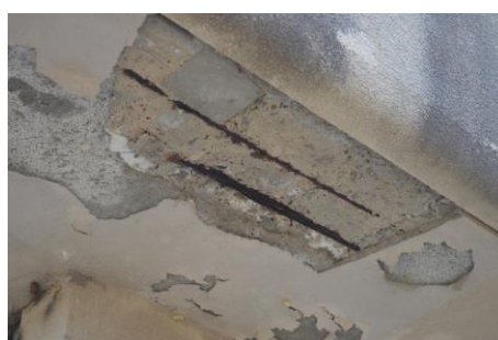
コンクリートの剥落
