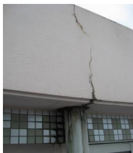
構造躯体のひび割れ
