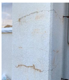
錆汁を伴うひび割れ
