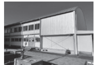
▲改修予定の竹原小体育館
