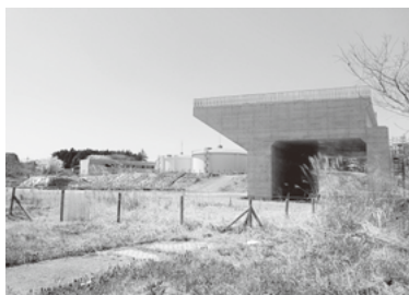
▲整備中の国道6号千代田石岡バイパス
