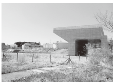
▲整備中の国道6号千代田石岡バイパス
