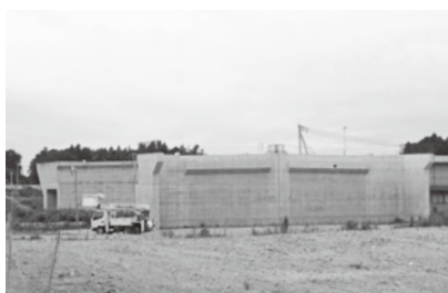
▲一般国道6号千代田石岡バイパス建設地（栗又四ヶ地内）
