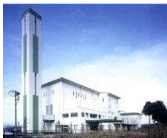
霞台厚生施設組合 環境センター
