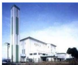
霞台厚生施設組合 環境センター
