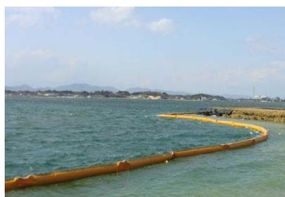
海洋への拡散抑制設備（汚濁防止膜）
