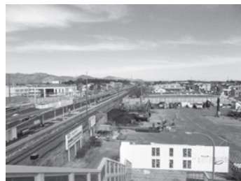
▲工事が進む羽鳥駅
