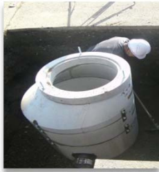
マンホール設置工事の様子
