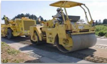
道路補修工事
