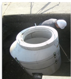
マンホール設置工事の様子
