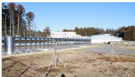
水道局の貯水タンク
