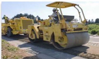
道路補修工事
