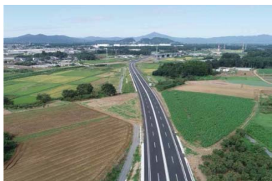
整備中の広域幹線道路
