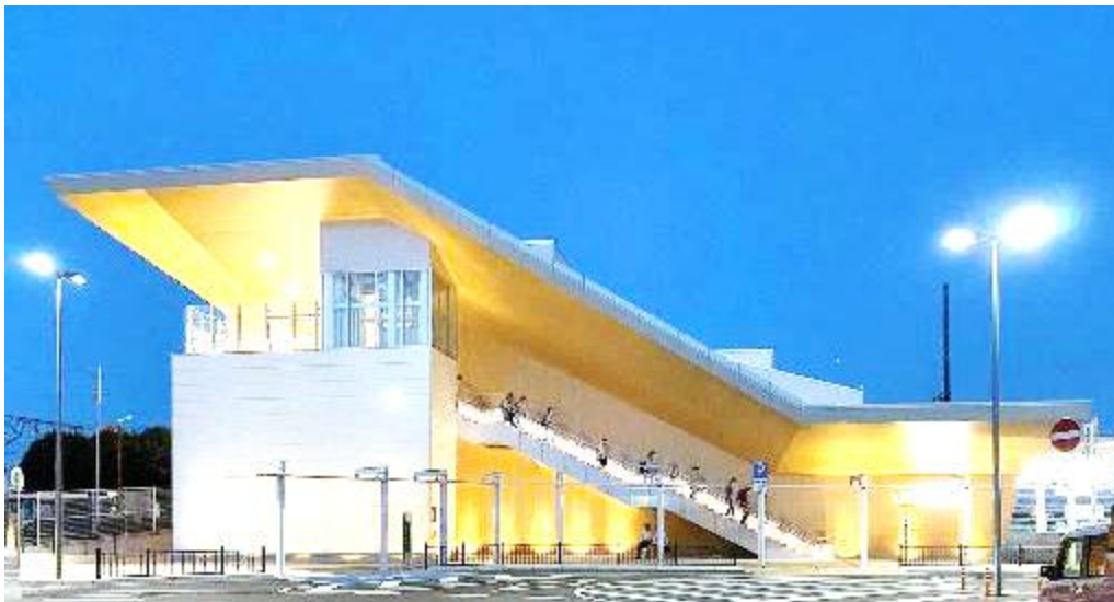
羽鳥駅橋上駅舎
