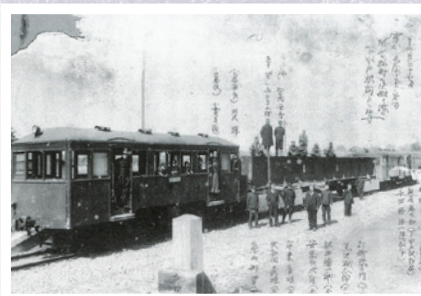
ながおか おくのや ▲長岡-奥ノ谷間鉄橋の橋桁運搬の水戸 おおわた つとむ 鉄道(故 大和田 努氏蔵)
